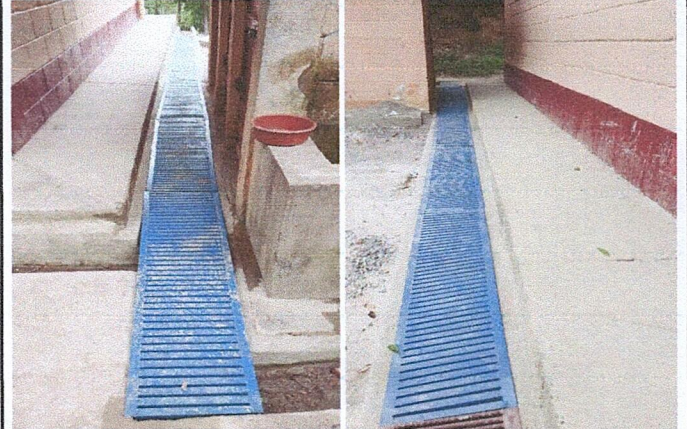
Foto 8: Area donde se instalo las dos rejillas metálicas para cunetas
