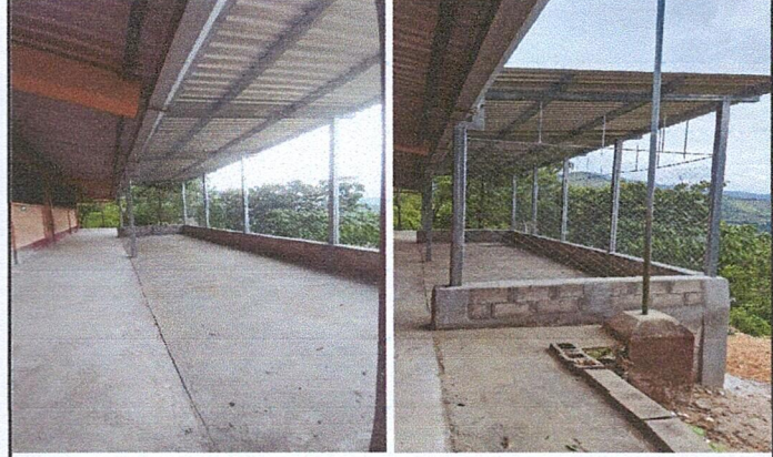
Foto 6: Area lateral donde se realizó Mejoramiento de muro de contención, mejoramiento de muro perimetral, Mejoramiento con estructura tipo portico y lámina troquelada calibre 26 y Mejoramiento de losa de piso.
