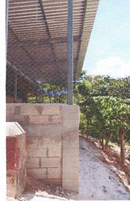
Foto 2: Area donde se realizó Mejoramiento de muro de contención, mejoramiento de muro perimetral, Mejoramiento con estructura tipo portico y lámina troquelada calibre 26 y Mejoramiento de losa de piso.
