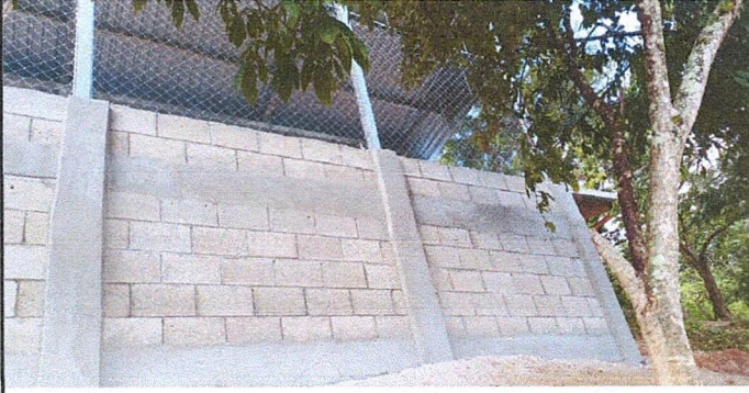
Foto 1: Area donde se realizó Mejoramiento de muro de contención, mejoramiento de muro perimetral, Mejoramiento con estructura tipo portico y lámina troquelada calibre 26 y Mejoramiento de losa de piso.
